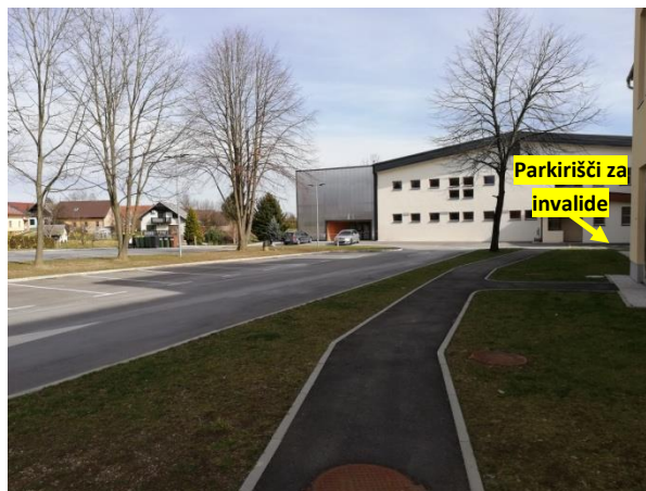
Slika 2: Parkirišče na severni strani OŠ Ormož
